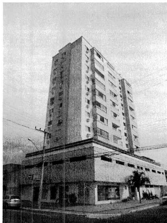
Vista do imóvel tomada desde a esquina da Av. José Eugênio Müller com a Rua Willy Hening
