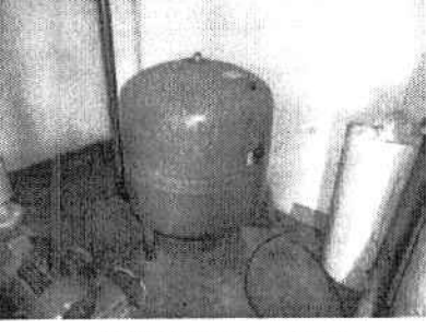
RESERVATÓRIO DE ÁGUA
