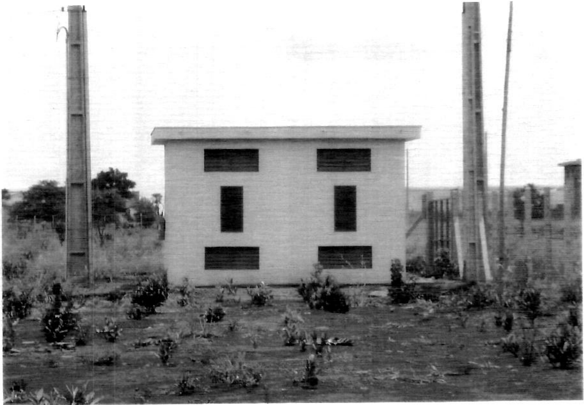
CASA DE FORÇA.
