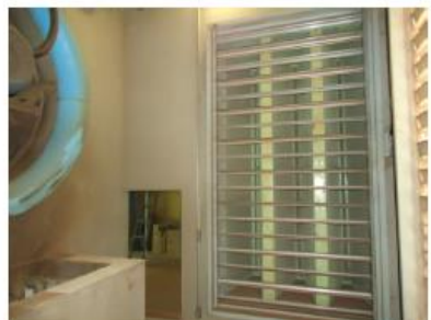
CENTRAL DE CLIMATIZAÇÃO - TELA FILTRAGEM
