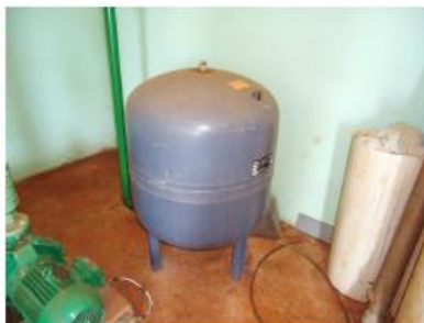
RESERVATÓRIO DE ÁGUA
