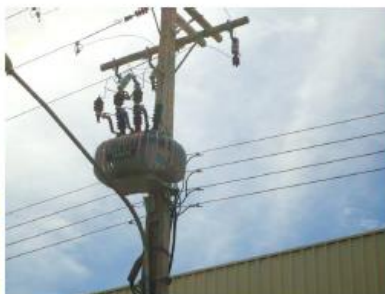
TRANSFORMADOR - POSTE
