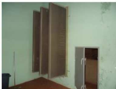
CENTRAL DE CLIMATIZAÇÃO - TELA FILTRAGEM
