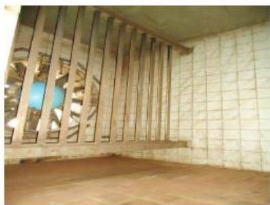
BARRAS PARA CONTENÇÃO DE ÁGUA
