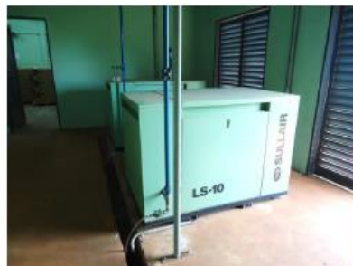
COMPRESSOR DE AR TIPO PARAFUSO
