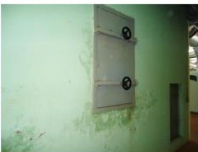
PORTA DE ACESSO - CENTRAL DE CLIMATIZ.
