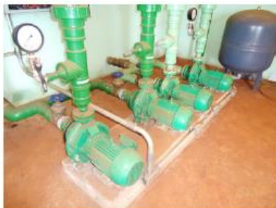
BOMBAS CENTRÍFUGAS
